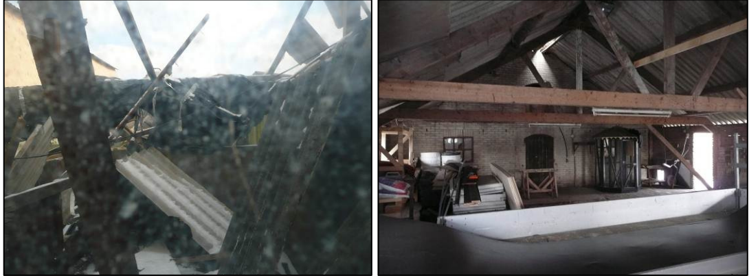
Binnenzijde van de schuren (Foto's Laneco).
