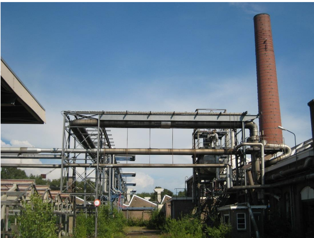
Afb. 15. Karakteristiek ruimtelijk beeld anno 2007: tussen gebouwen opgezette transportsystemen en buizenstelsels (luchtafzuiging e.d.) bepalen voor een groot deel het karakter van de openbare ruimte op het terrein. (Bron: Monumentenzorg Gemeente Ede)
