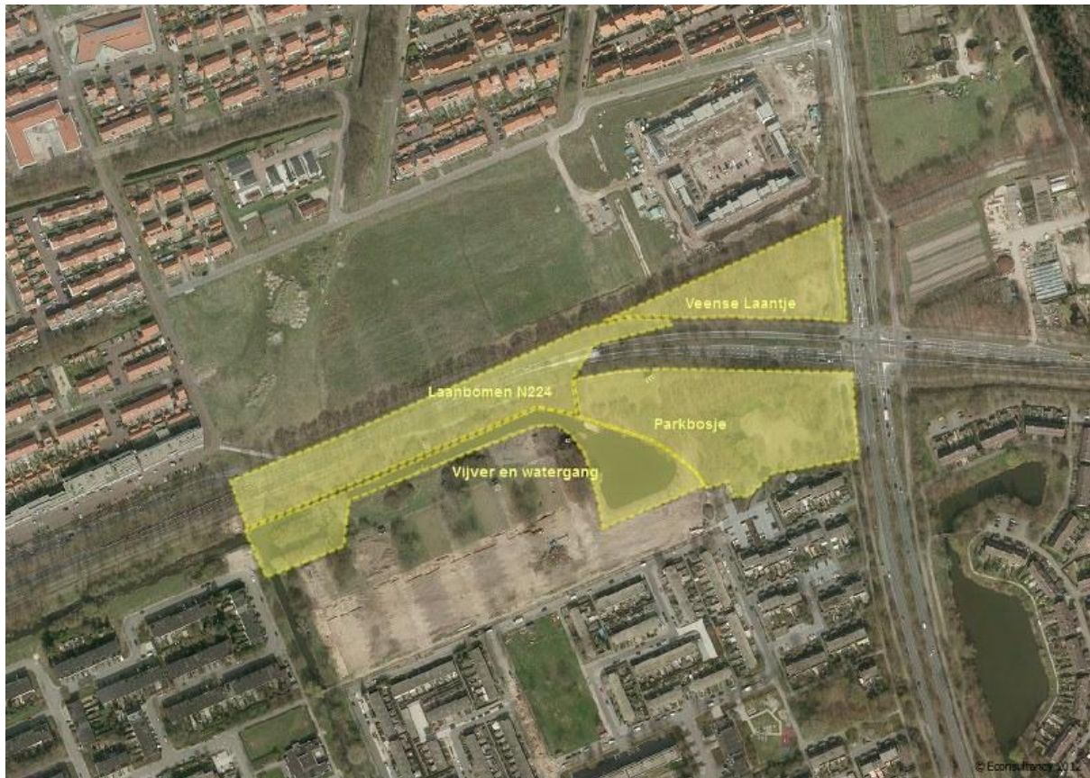
Figuur 1 Luchtfoto (2010) van de onderzoekslocatie met ligging deelgebieden
