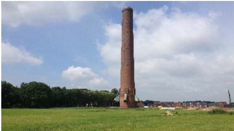
Figuur 3: De schoorsteen
