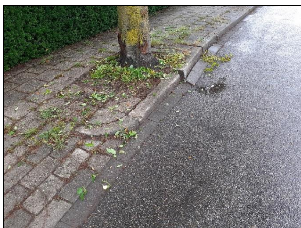
Figuur 7: Aan de IJssel de Schepperlaan opdruk verharding en wegdrukken van de opsluitband
