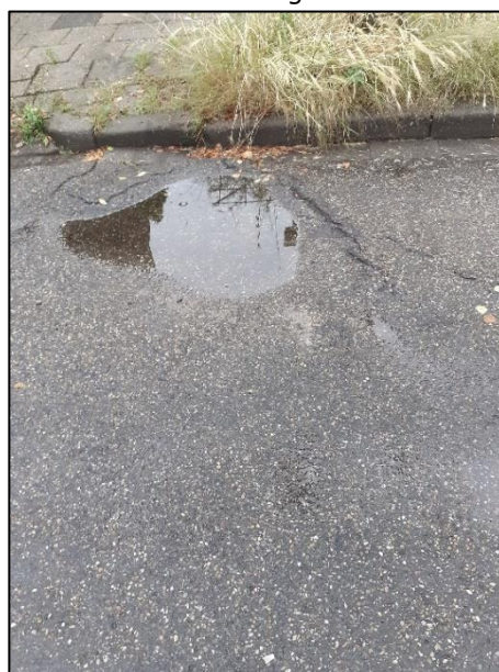
Figuur 5: Wortelopdruk aan de Van Voorthuizenlaan
