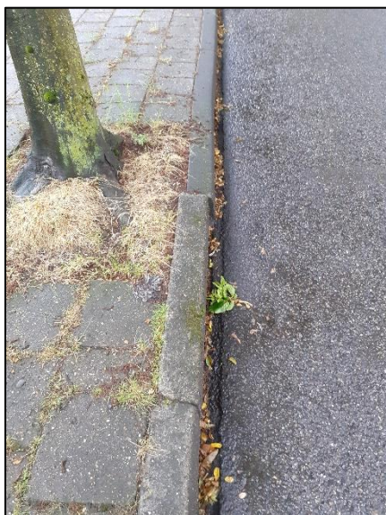
Figuur 6: Opdruk verharding aan de Thomaslaan en wegdrukken van de opsluitband
