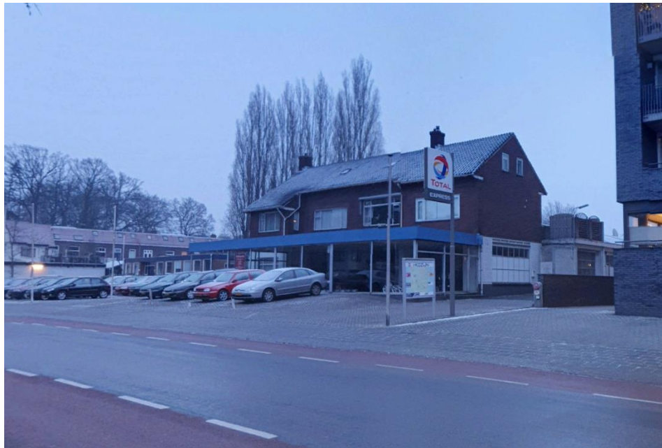
De bestaande situatie op de locatie Stationsweg 111-115. Momenteel een vrijstaand pand bestaand uit twee bouwlagen met zadeldak. De foto staat tussen de molen en de garage. 3
