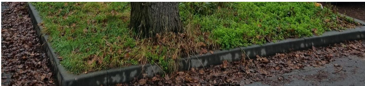
Afbeelding 15: Bestaande situatie: trottoirband rondom boom 3.
