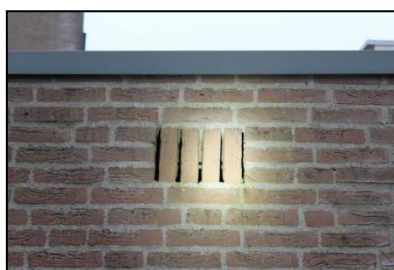
Figuur 10. Ventilatieopeningen met achterliggende ruimte.
