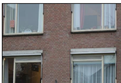
Figuur 9. De bebouwing is voorzien van veel open stootvoegen.
