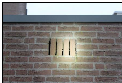
Figuur 12. Ventilatieopeningen met achterliggende ruimte.
