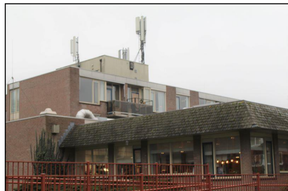
Figuur 10. Platte daken en schuine daken met shingles.
