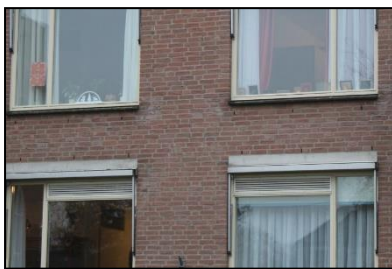
Figuur 11. De bebouwing is voorzien van veel open stootvoegen.
