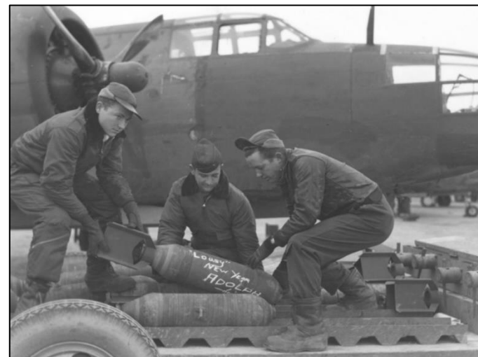
Figuur 5 t/m 7. Links: Een doorsnede van een 260 lb fragmentatiebom; een AN-M103 ontsteker; boven, rechts: Een 260 lb fragmentatiebom wordt in een bommenwerper geladen. Bron: collectie BeoBOM/iwm.org.uk.
