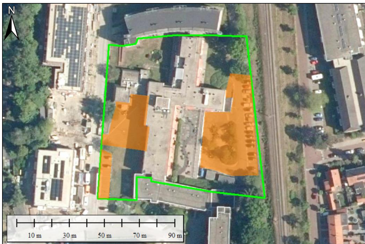
Figuur 28. Binnen het onderzoeksgebied aangelegde infrastructuur (oranje).
