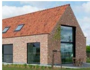
Terugkerende gevelopeningen in de zijgevels
