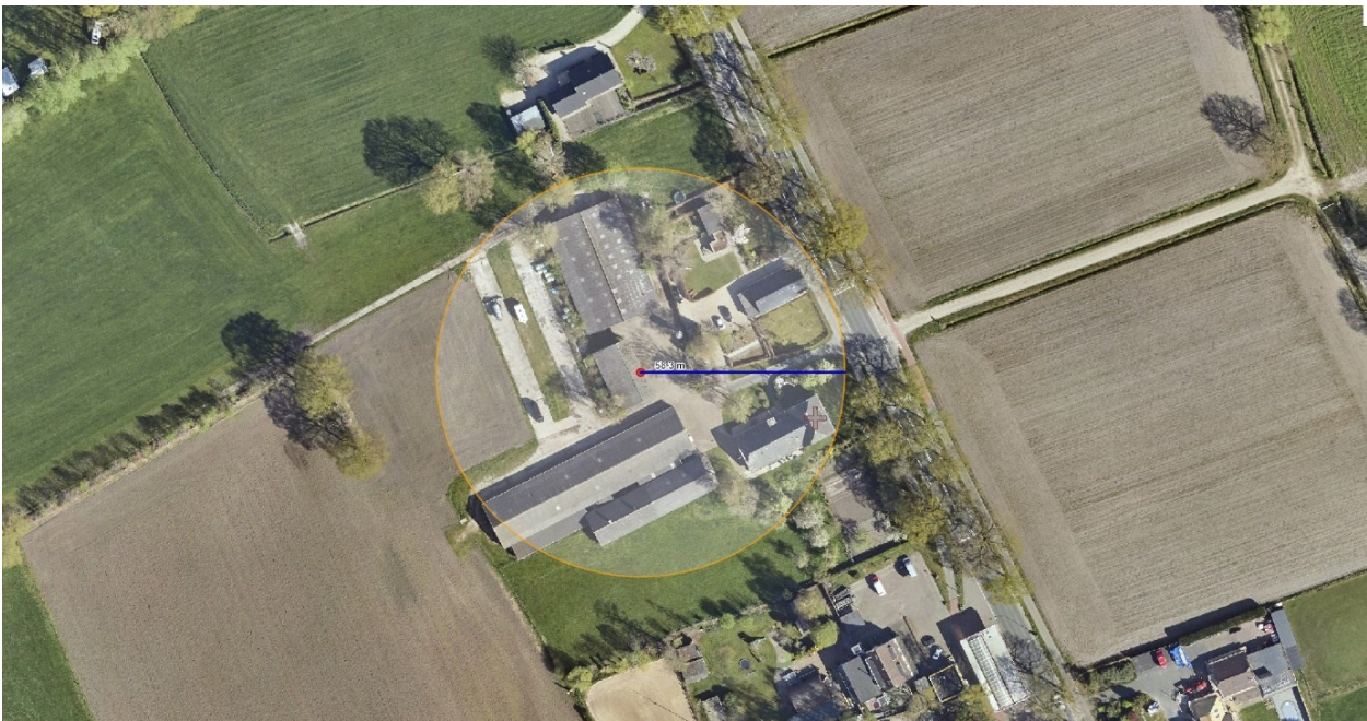
luchtfoto huidige situatie
