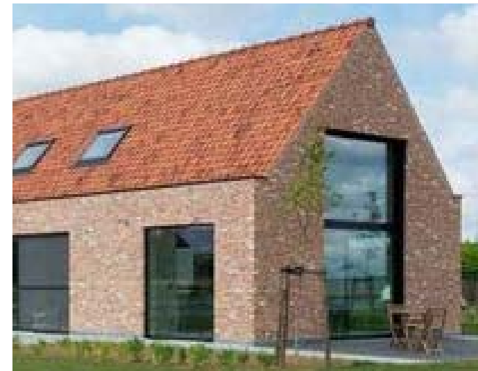
Terugkerende gevelopeningen in de zijgevels
