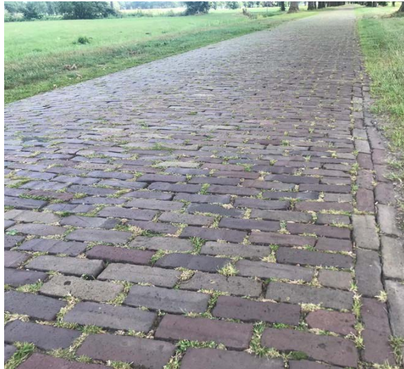
Hoofdverharding in oud gebakken klinkers
