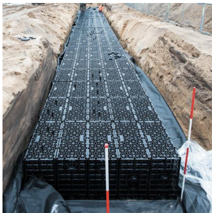
Figuur 4. Voorbeeld ingraven kratten (uitsnede folder Jobi-Cell/Polystorm)
