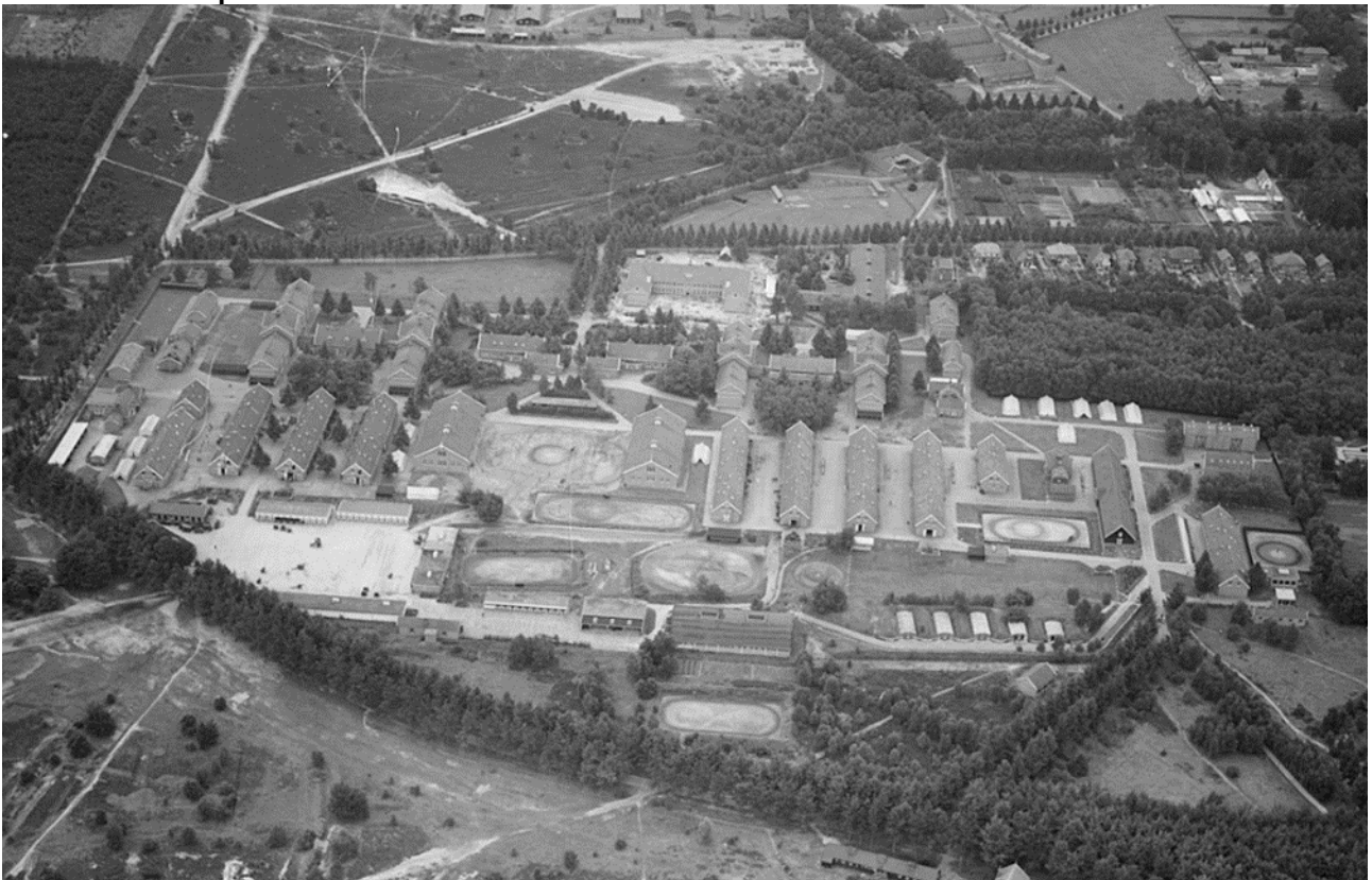
Het kazernecomplex van de Mauritskazerne in 1935.
