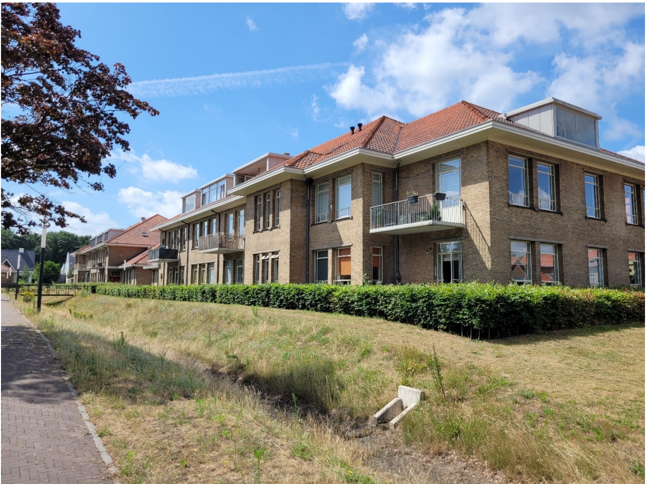
Afb. 7: Voormalige kazernesgebouwen monumentaal cluster EBK
