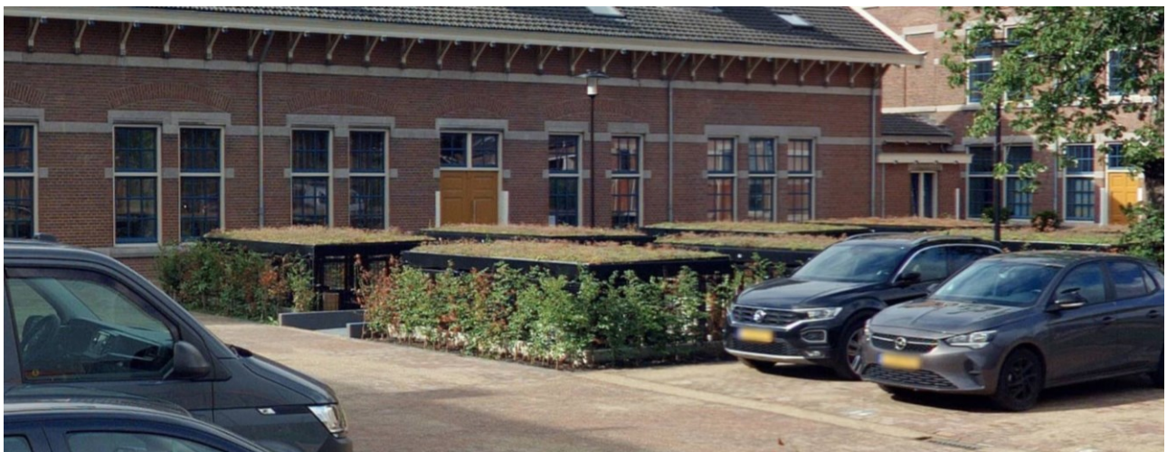
Afb. 8: verdiept fietsparkeren met lage groene overkapping
