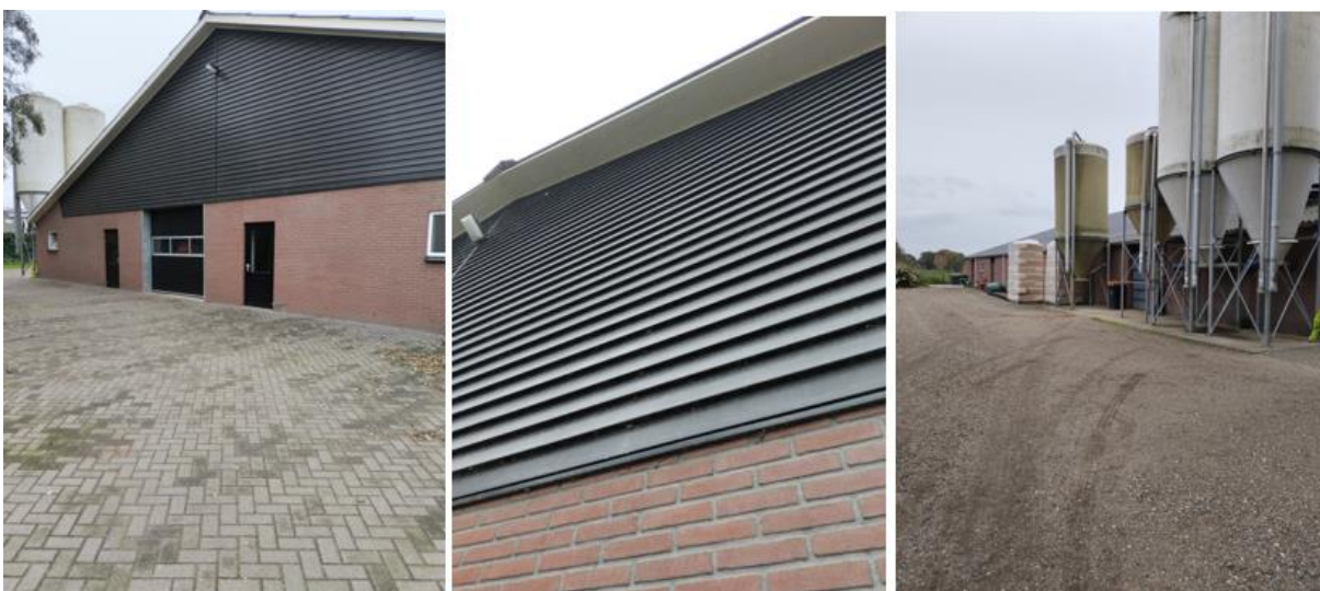
Grote veestal volledig afgesloten. Ventilatie openingen zijn dicht door middel van roldeuren. Achter de deuren is gaas aanwezig.
