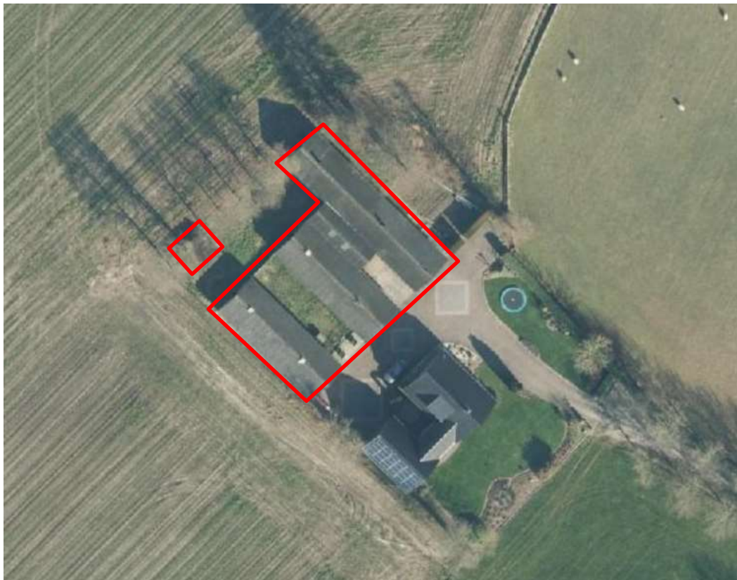
Afbeelding 1, globaal overzicht van de te slopen bebouwing (rode contour) binnen het plangebied (ondergrond: PDOK viewer, 2023).
