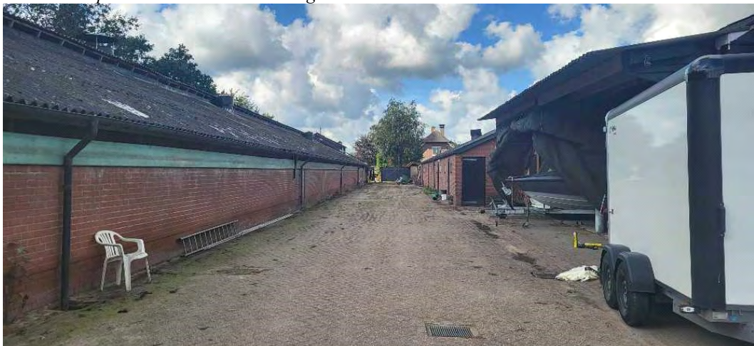
Foto 2: drupzone met klinkerverharding
