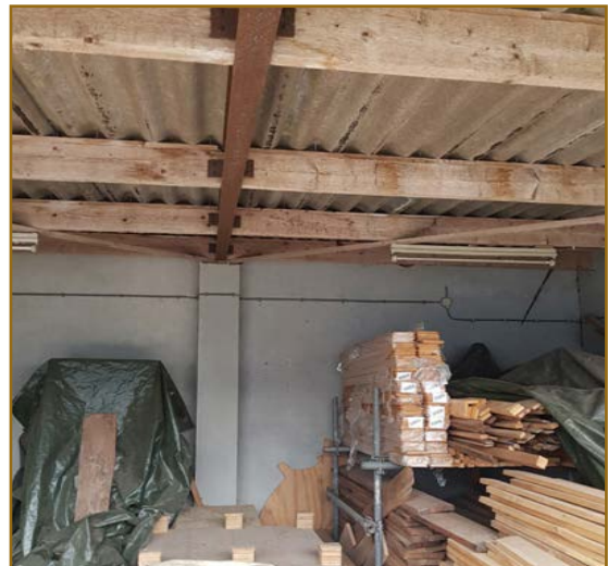
Afb. 2.16: Enkele muur aan bijgebouw tegen gebouw 4.
