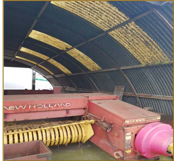
Afb. 2.8: Overkapping van gebouw 6
