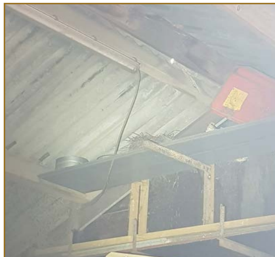
Afb. 2.11: Nest aanwezig in gebouw 5.
