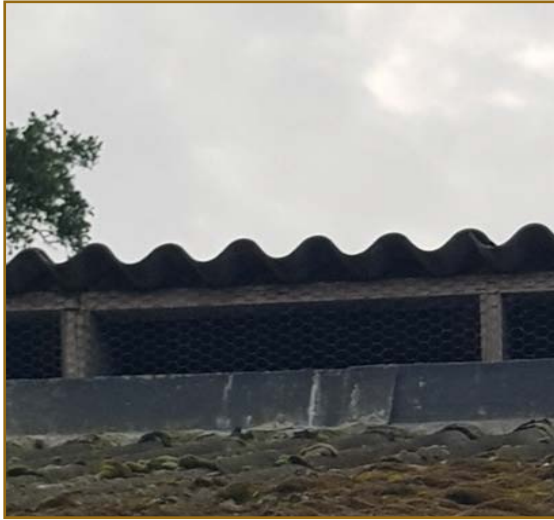
Afb. 2.13: Gebouw 3 en 4 voorzien van gaas.
