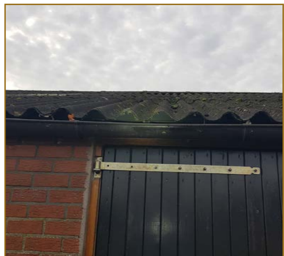
Afb. 2.6: Onder de golfplaten van gebouw 3 en 4 is schuimrubber aanwezig.
