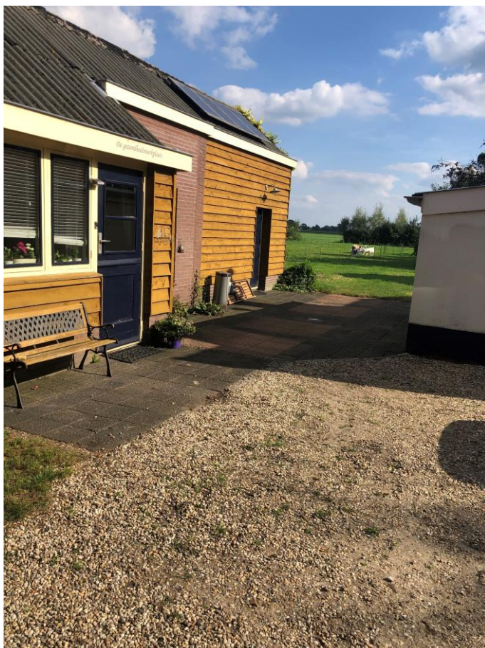
Bijgebouw waarin HBO tank heeft gestaan
