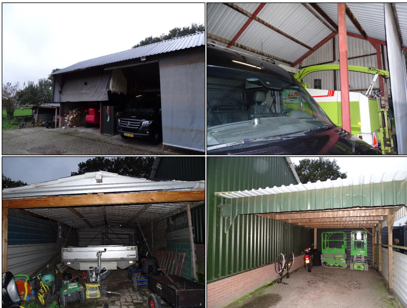
Afbeelding 2, indruk van de te slopen bebouwing binnen het plangebied met linksboven de voorzijde van de kapschuur, rechtsboven de binnenkant van de kapschuur, linksonder het aangrenzende schuurtje aan de zuidzijde en rechtsonder een overkapping aangrenzend aan de noordzijde (foto's: Laneco, 2023).
