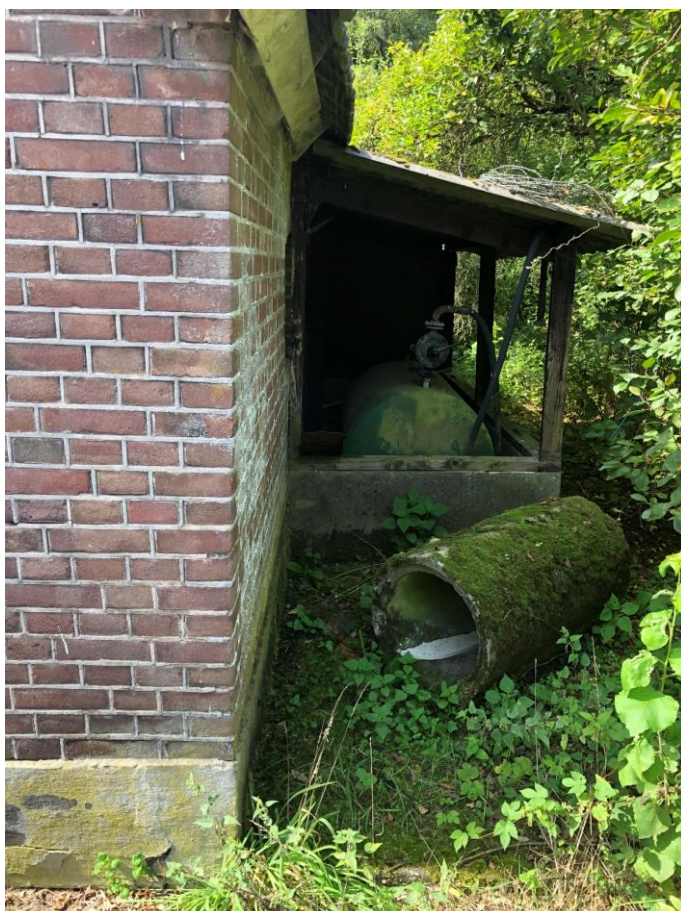
Dieseltank bij schuur 3
