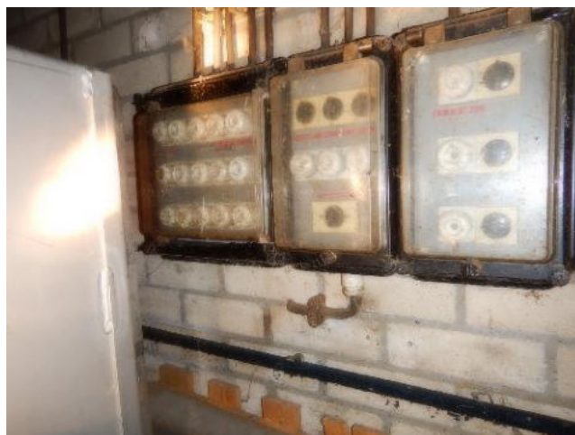
Elektra installatie niet asbesthoudend
