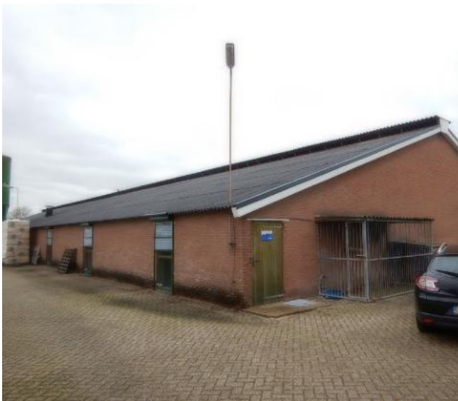
Bron 1 Golfplaten op schuur
