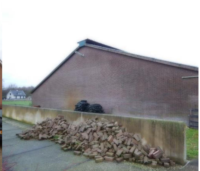
Bron 1 Golfplaten op schuur (2)
