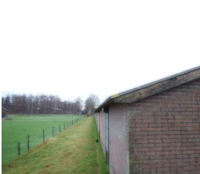
Bron 1 Golfplaten op schuur (3)
