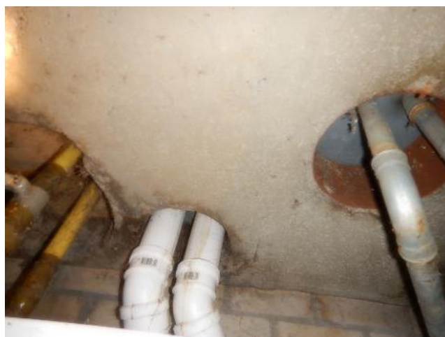
Ontluchtingen niet asbesthoudend
