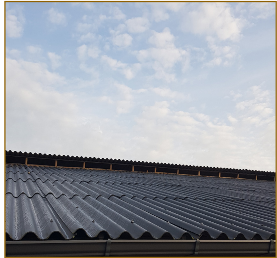
Afb. 2.2: Het dak van de schuur bestaat uit golfplaten. Aan de bovenzijde is gaas bevestigd.
