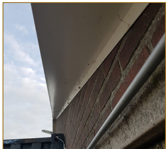
Afb. 2.6: Een stalen overstek die strak aansluit op de muur, waardoor de spouw afgesloten is.
