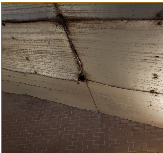
Afb. 2.7: Een gat in de isolatie, maar geen sporen die op de aanwezigheid van marterachtigen wijst.
