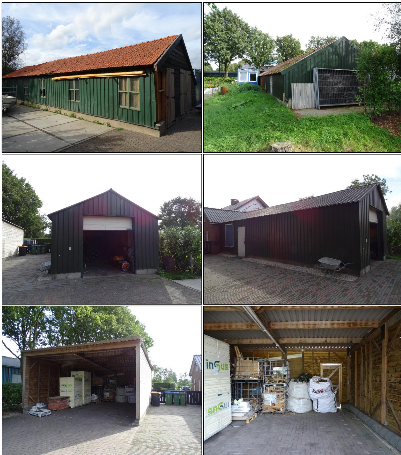
Afbeelding 2, overzicht van de schuren binnen het plangebied met bovenaan schuur 1, middenin schuur 2 en onderaan (kap)schuur 3, (foto's Laneco, 2023).
