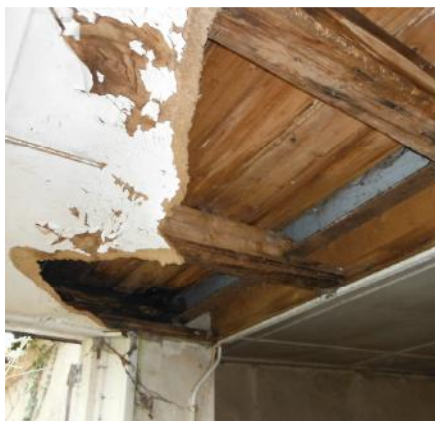
Geen asbest boven zachtboard plafond
