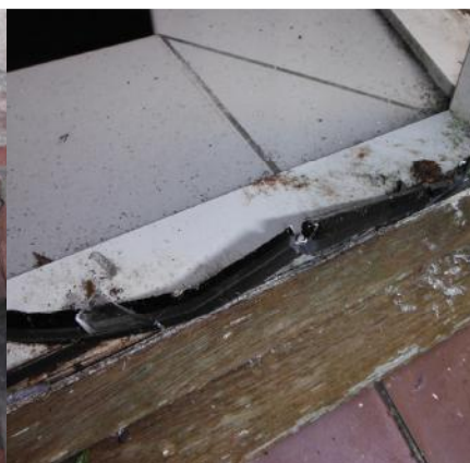
Rubber afdichtingen kozijnen woning
