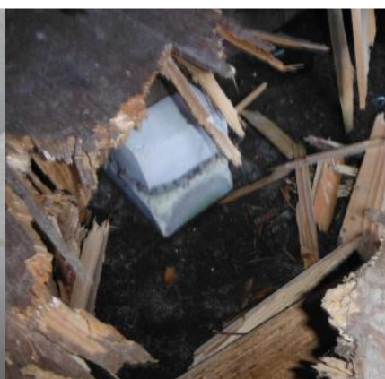
Onder houtenvloer geen asbest aangetroffen
