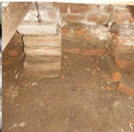
Fundering geen asbest aangetroffen
