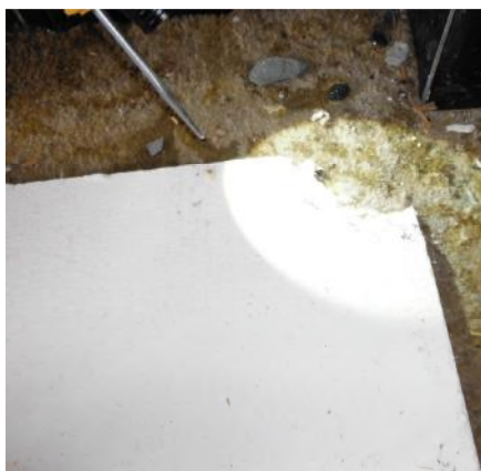
Plaat op vloer eetkamer niet asbesthoudend
