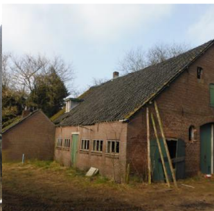
Schoor 5 aan woning bevat geen asbest
