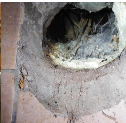
Geen asbest in rookgaskanaal
