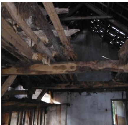
Tegen binnenzijde dak schoor 5 geen asbest aanwezig
