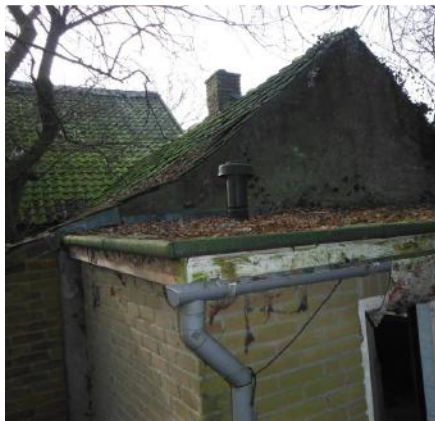
Dakbedekking aanbouw naast keuken niet asbesthoudend
