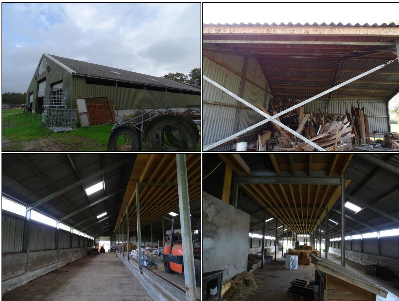
Afbeelding 2, indruk van de te slopen bebouwing binnen het plangebied met linksboven een overzicht van de veestal, rechtsboven een overzicht van de overkapping welke tegen de westelijke schuur is aangebouwd en onderaan een overzicht van de binnenzijde van de veestal (foto's: Laneco, 2023).
