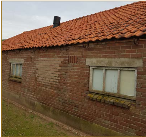
Afb. 2.1: Westkant van schuur 2. De houten balk op de muur is te zien.
