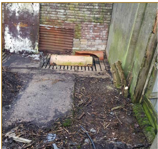
Afb. 2.13: Binnenkant van schuur 7.
