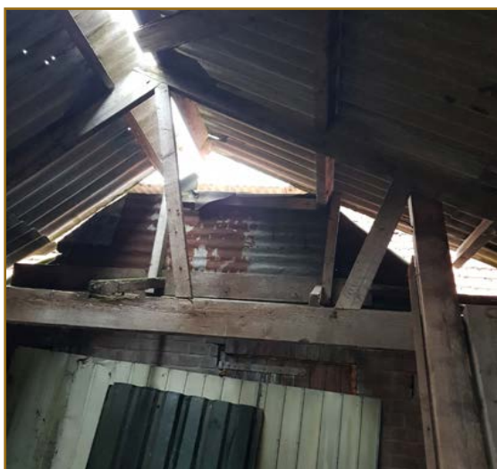
Afb. 2.15: Binnenkant van schuur 4.
