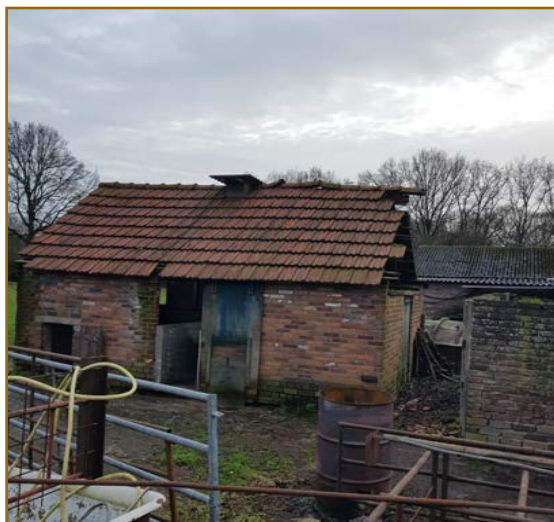
Afb. 2.9: Foto van schuur 6.
