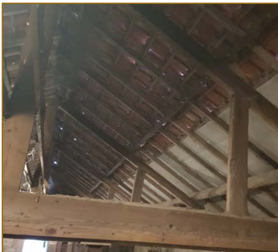
Afb. 2.5: Binnenkant van schuur 2.
