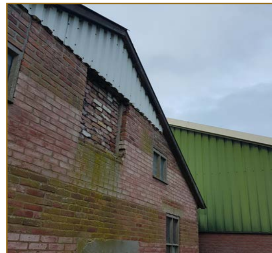
Afb. 2.12: Metalen wandbeplating van schuur 5 zit dicht met isolatiemateriaal.
