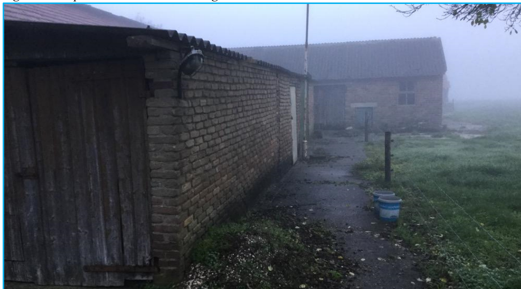
Figuur 6: drupzone met betonverharding
