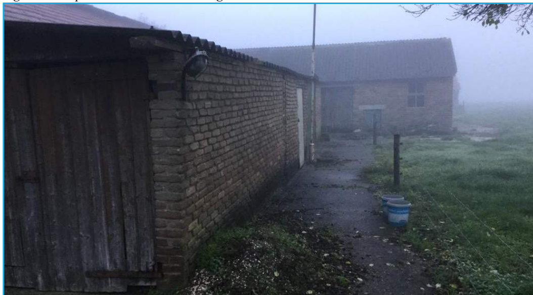
Figuur 6: drupzone met betonverharding
