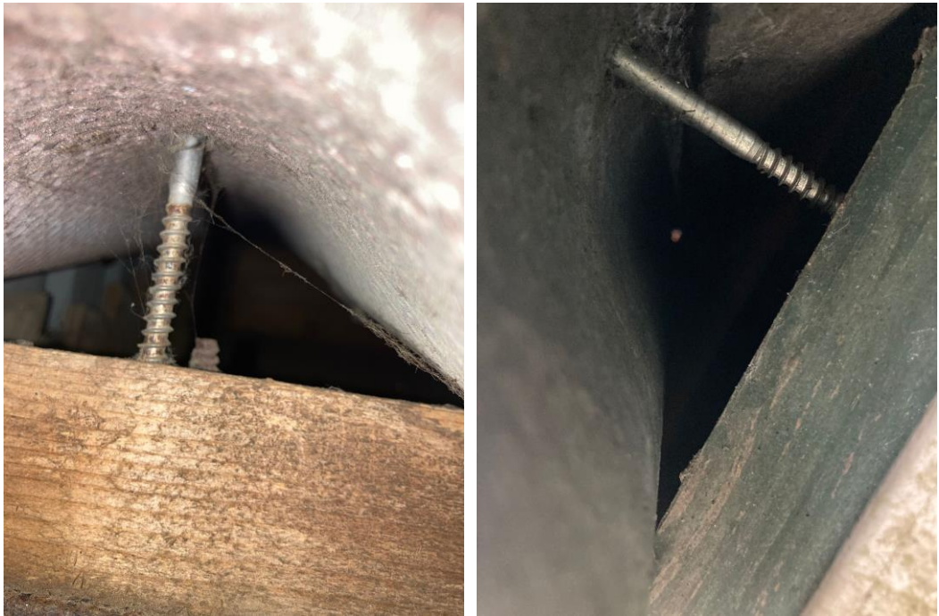
Alle ruimtes onder de dakplaten zijn geïnspecteerd.
