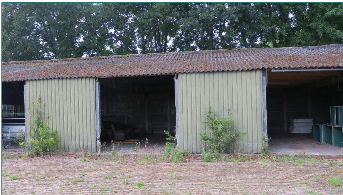
Figuur 3 De kapschuur (gebouw 7) waarin braakballen van de kerkuil zijn aangetroffen.
