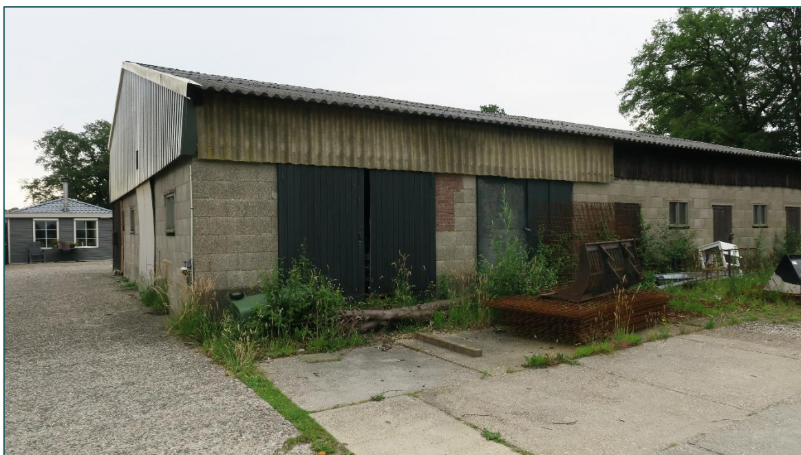
Figuur 2 Eén van de gebouwen op de planlocatie welke gesloopt zullen worden.
