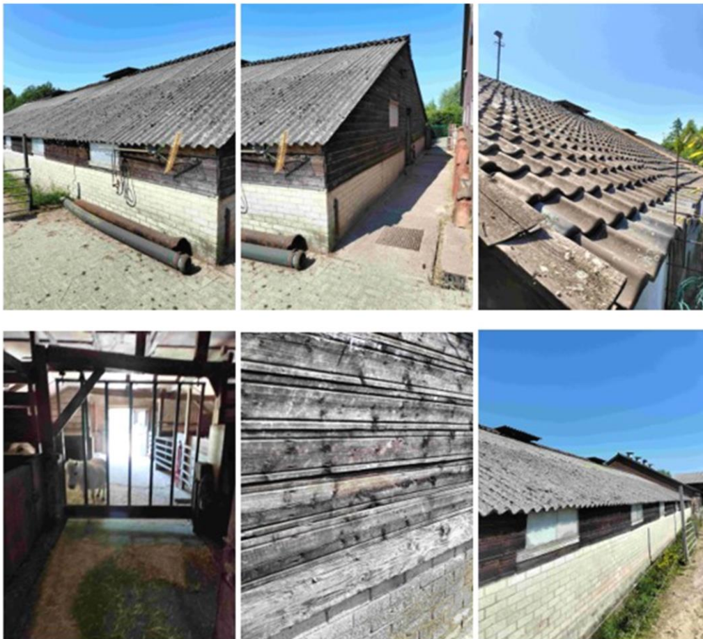
Foto impressie van de te slopen veestal.
