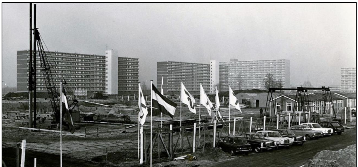
Afbeelding 19: foto van de afgraving van het gebied, genomen vanuit de zuidoost kant van het gebied in noordwestelijke richting, voor de aanleg van gebouw 2 (het T-vormige gebouw. Bron: Kudo bouw B.V.)
