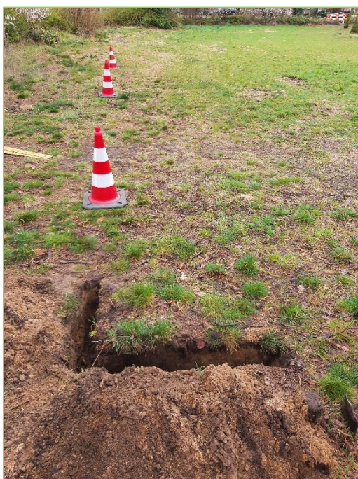
Overzicht profielsleuf. De pionnen geven de lijn van de toekomstige gevels weer.
