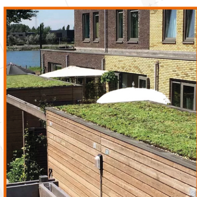
begringen met groene (sedum) daken
