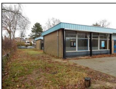
Figuur 4. Laagbouw met plat dak.
