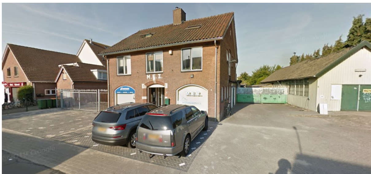
Afbeelding 2.1: Aanzicht bestaande situatie plangebied (bron: Google Street View)
