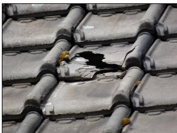
Figuur 14. Doordat het dak op veel plaatsen beschadigd is, hebben wind en regen vrij spel en is het dakbeschot op veel plaatsen weggerot.
