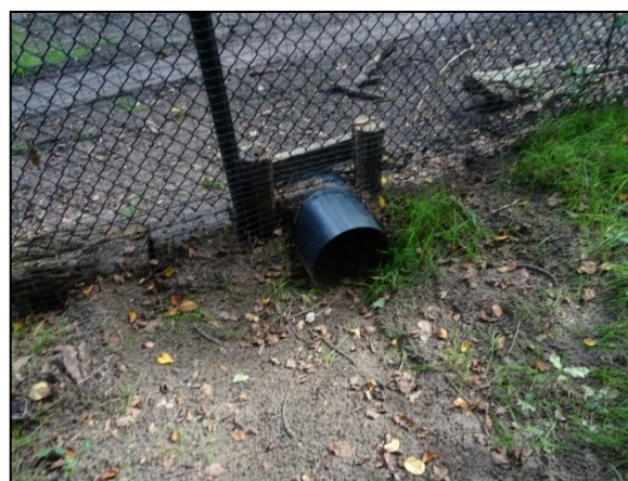
Figuur 13. Faunapassage voor soorten als de das bij hekwerk Hoge Veluwe.
