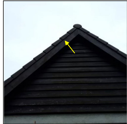
Figuur 2. Zomerverblijfplaats gewone dwergvleermuis in elektriciteitshuisje.
