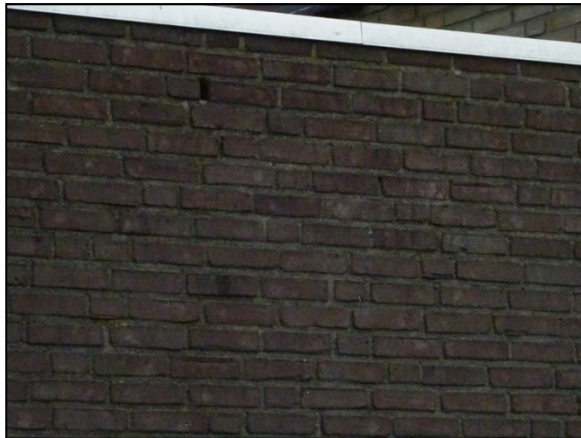
Figuur 28. Open stootvoeg bij uitbouw aan de westzijde van de Sero.
