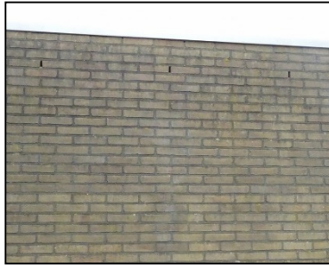
Figuur 25. Open stootvoegen bij Onderlangs.
