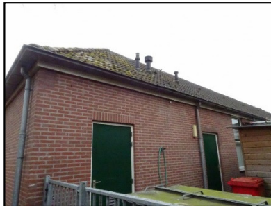
Figuur 16. Dorpshuis met pannendak en gevels met open stootvoegen.
