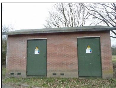
Figuur 7. Elektriciteitshuisje met leren dak.
