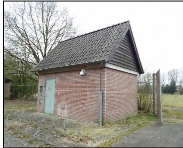
Figuur 26. Overhangende kantpannen en ruimte bij overstek van noordelijke elektriciteitshuisje.
