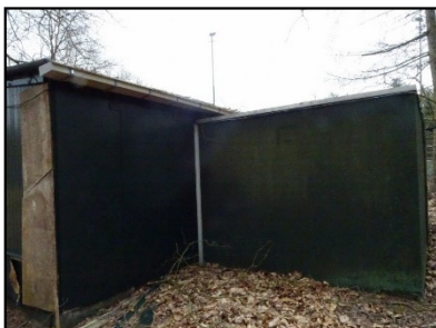
Figuur 13. Houten kleedruimten met leren dak.
