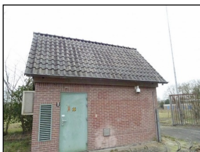
Figuur 6. Elektriciteitshuisje met pannen dak.
