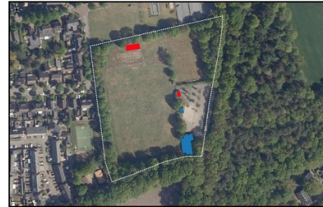
Figuur 27. Geschikte bebouwing (rood) en ongeschikte bebouwing (blauw) voor vleermuizen.
