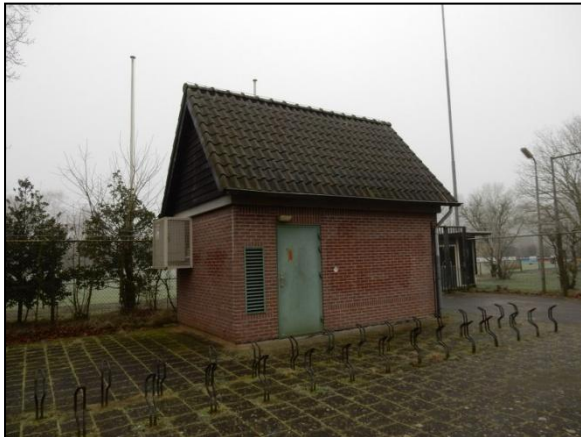
Figuur 12. Elektriciteitsgebouw biedt voor vleermuizen geschikte verblijfsmogelijkheden.
