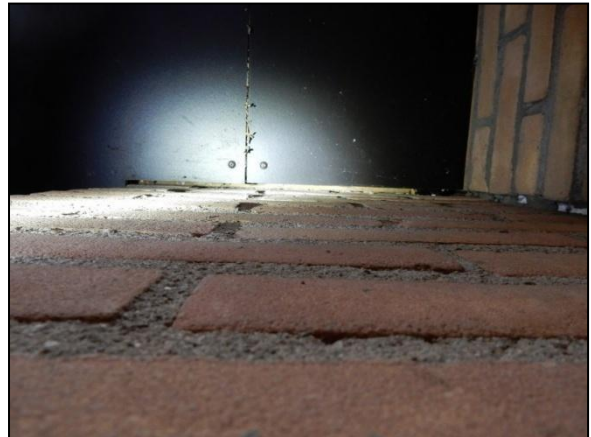
Figuur 13. Ruimte achter betimmering van het kantinegebouw.
