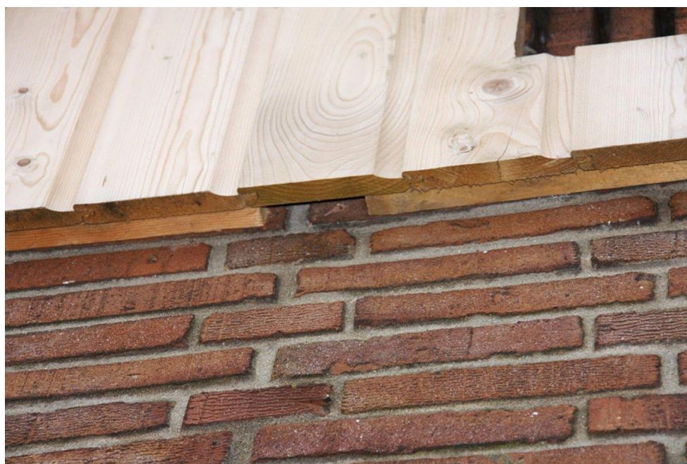
Afbeelding 5: Schematische tekening van het vleermuis geschikt maken van gevelbekleding (boven) en een foto van toegepaste gevelbekleding (onder) (bronnen: Vleermuis in de stad, 2022; Checklist groen bouwen, 2022)
