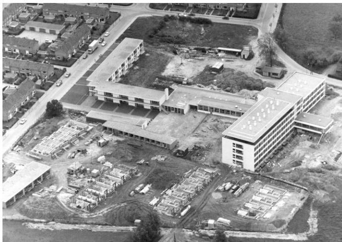
Luchtfoto van het bejaardencentrum tijdens de bouw aan het einde van de jaren 60 (bron: Gemeentearchief Ede, inventarisnummer GA34620).
