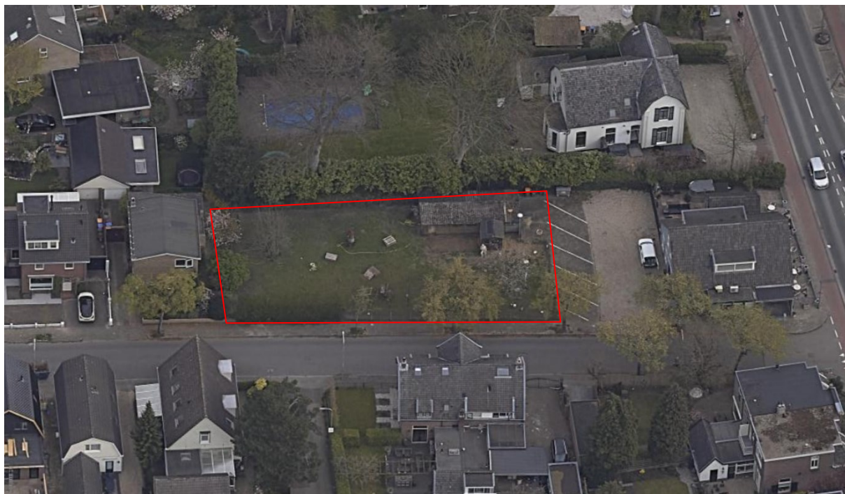
Afbeelding 2.1: Luchtfoto bestaande situatie
