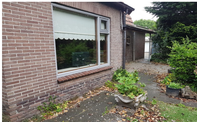
Foto 2: tuin/terras, oostzijde woonhuis
