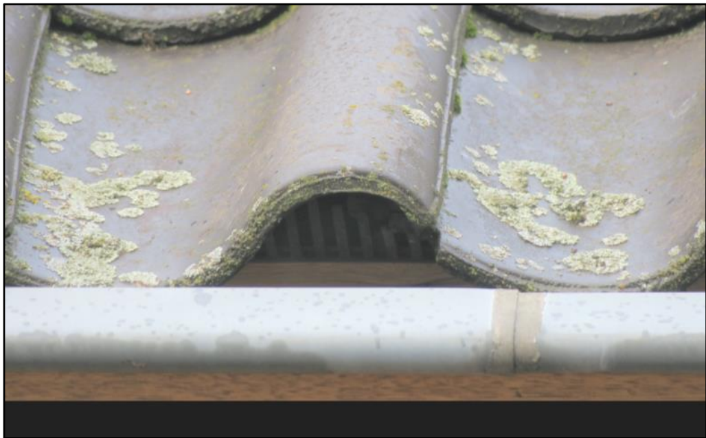
Figuur 4 Zoals zichtbaar bevat het dak van de woning onder de eerste rij dakpannen vogelschroot.
