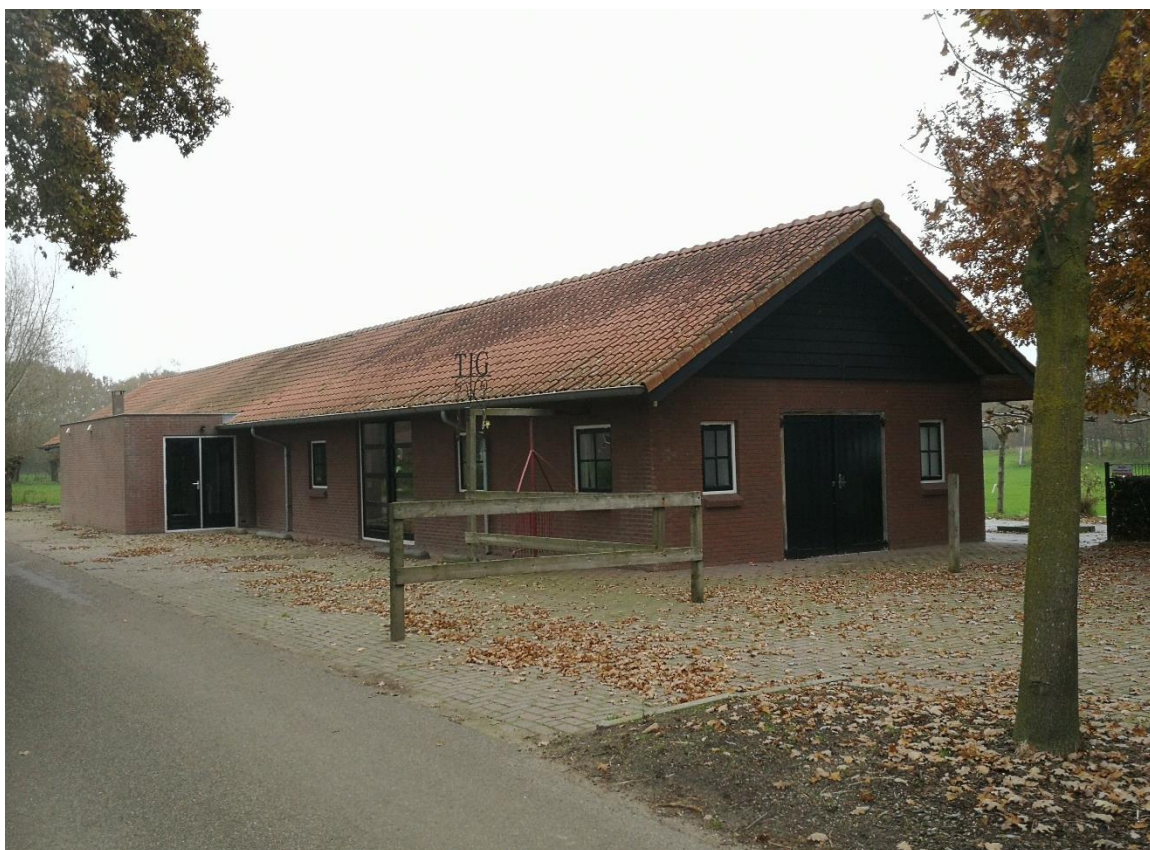
Figuur 4 Voormalige ijsbaankantine.
