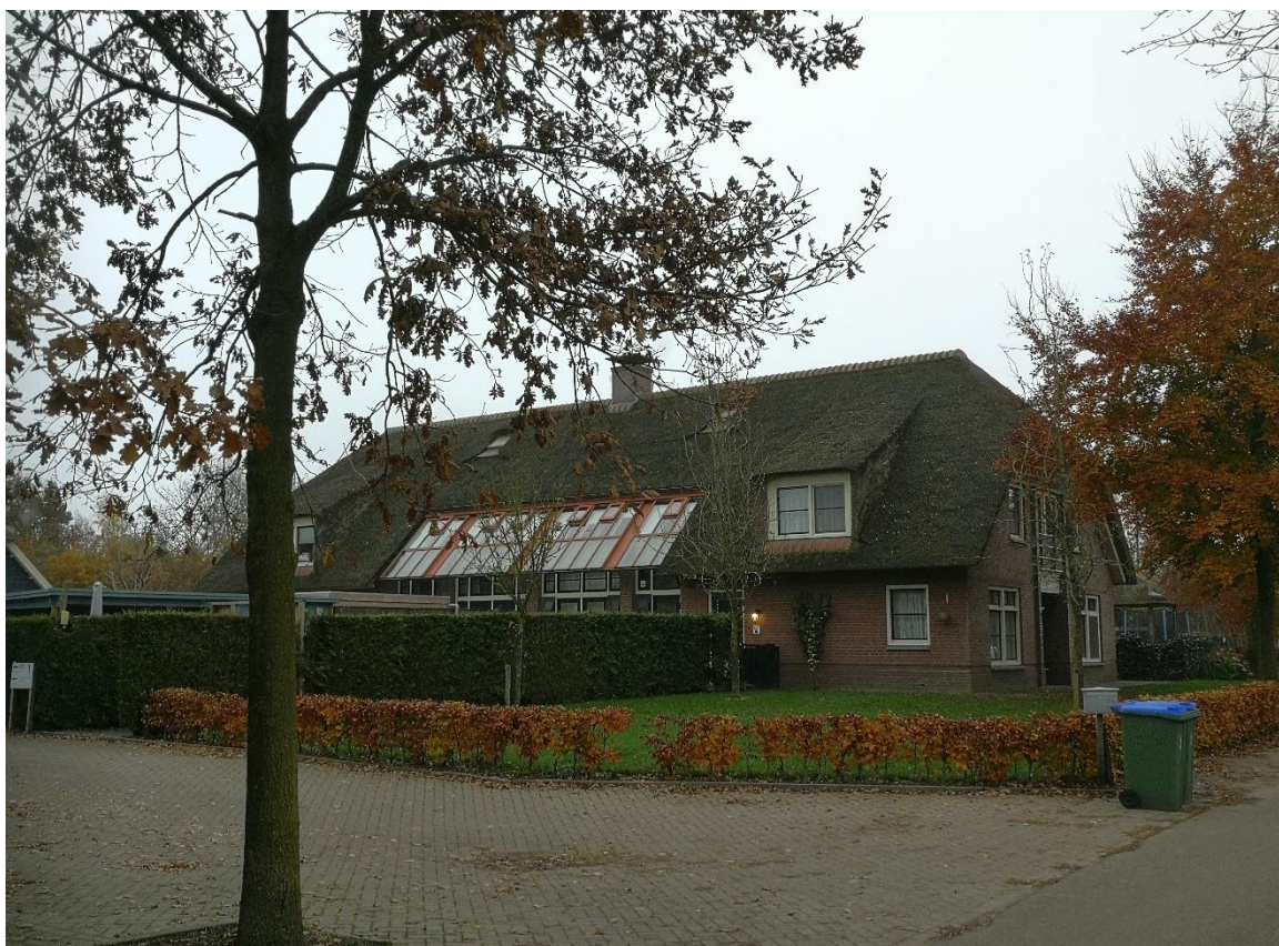
Figuur 2 Het huidige Thomashuis, gezien vanuit westelijke richting.
