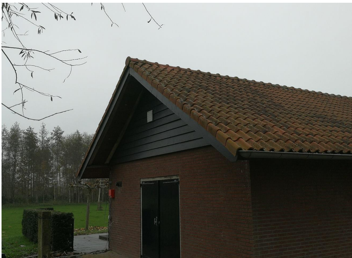
Figuur 11 Oude ijsbaankantine met potentiële verblijfplaatsen van vleermuizen in de dakconstructie.
