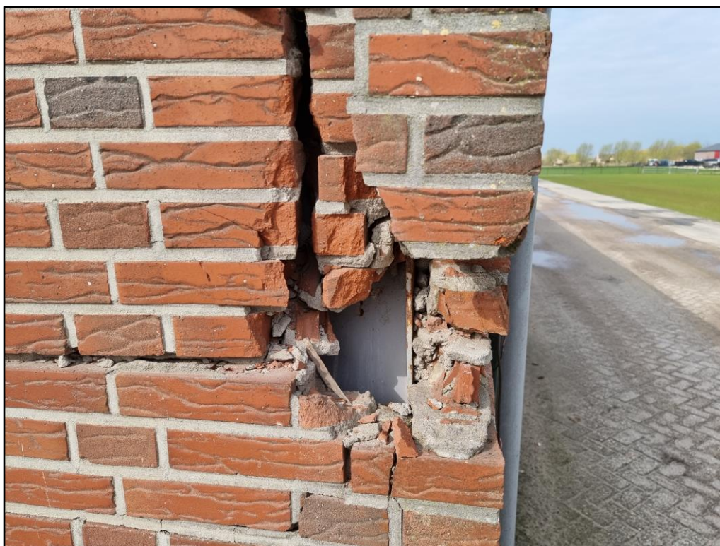
Figuur 2 De schuren bevatten geen spouw en verkeren in vrij erbarmelijke staat.
