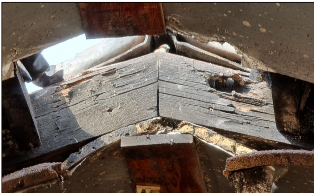
Figuur 3 Een van de open delen in de zuidelijke schuur waar huismussen nestgelegenheid kunnen vinden tussen het isolatiemateriaal en de golfplaten.
